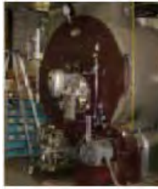
(1) 炉筒煙管ボイラー正面側 ボイラー(8t/h) 測定環境30℃
