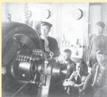
小田原馬車鉄道会社電化工事実習 回転変流機
