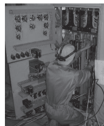
【施工事例】 盤更新工事
