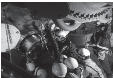
【施工実績】 北海道電力様石狩湾新港発電所
