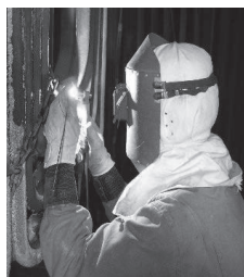
【施工事例】 ボイラ修繕工事
