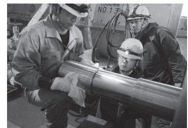
【施工事例】 ポンプ更新工事
