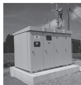
屋外用キュービクル式 高圧受電設備
