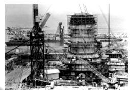
6 建設中の原子力発電所*1
