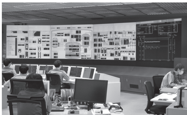
[写真：中央制御室] 原子炉を起動した美浜3号機の中央制御室。安全対策の一環で制御盤などがデジタル化された 提供：関西電力
