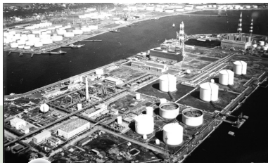
7 世界初のLNG専焼である南横浜発電所 ※1
