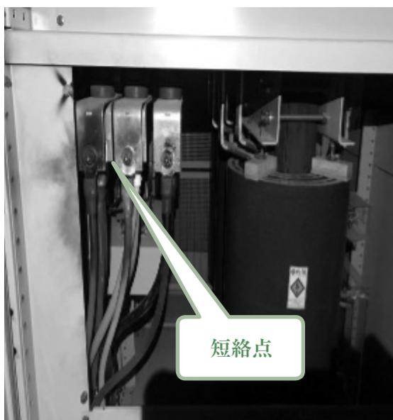
写真3 短絡した420V銅バー端子部
