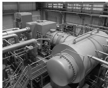
自社設備の多気バイオパワー。軸流排気タービンを採用し、建物の構造が簡略化されるとともに、排気損失の低減によるタービン効率の向上が図られ、燃料チップの消費量が節減できます。
