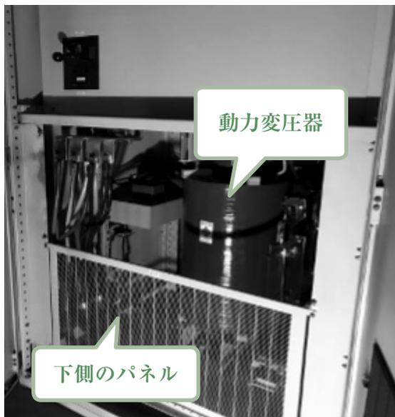
写真2 上側パネルを外した状況
