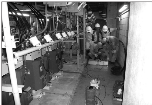
工事竣工試験 現場立会
