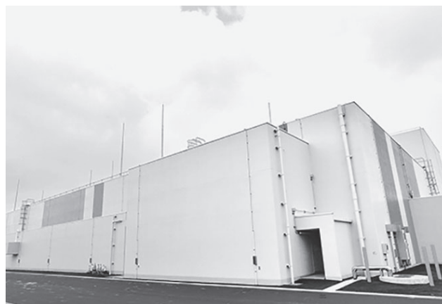
重大事故対策の拠点として新設した緊急時対策所
