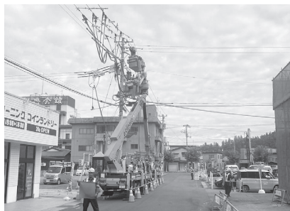
高所作業車での作業風景です。
