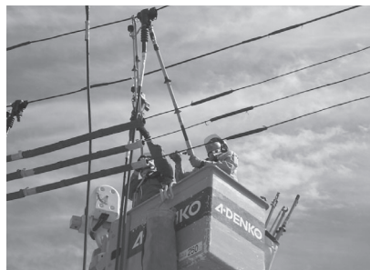
専用工具を使用した間接活線作業によってお客さまを停電させない工事をより安全に施工しています。
