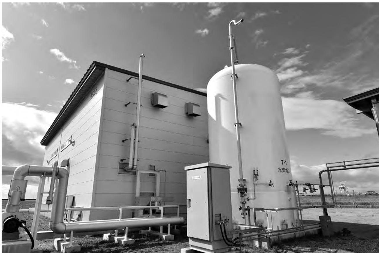
苫東厚真発電所の隣接地で製造した水素を貯蔵するタンク
