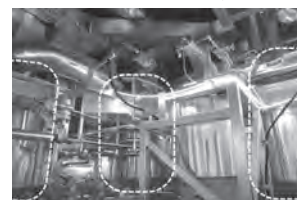
フィルタ付 格納容器ベント装置
